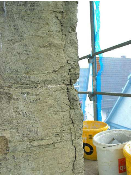
Abb. 3 links oben: Starke Schollenbildung Abb. 4 rechts oben: Diverse lose Putzschichten Abb. 6 links unten: Abschollung am Eckquader Abb. 7 rechts unten: Abschollung Fensterbank (Alle Fotos: Mäule und Krusch)
