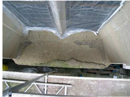
Abb. 3 links oben: Starke Schollenbildung Abb. 4 rechts oben: Diverse lose Putzschichten Abb. 6 links unten: Abschollung am Eckquader Abb. 7 rechts unten: Abschollung Fensterbank (Alle Fotos: Mäule und Krusch)
