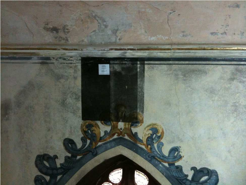
Abb. 8: Nordwand. Referenzfläche Urzustand und Reinigungsschritte (Foto: G. Mavridis)
